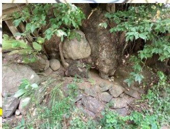
石が落ちてくかもしれない
